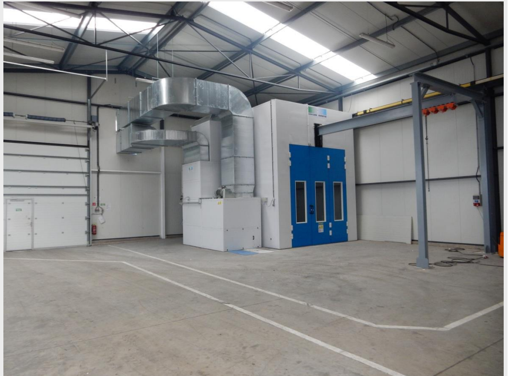
Kontinuálne pracovisko povrchovej úpravy – dokončenie montáže (december 2014):
